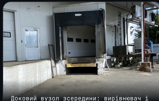
Доковий вузол зсередини: вирівнювач і докшелтер
