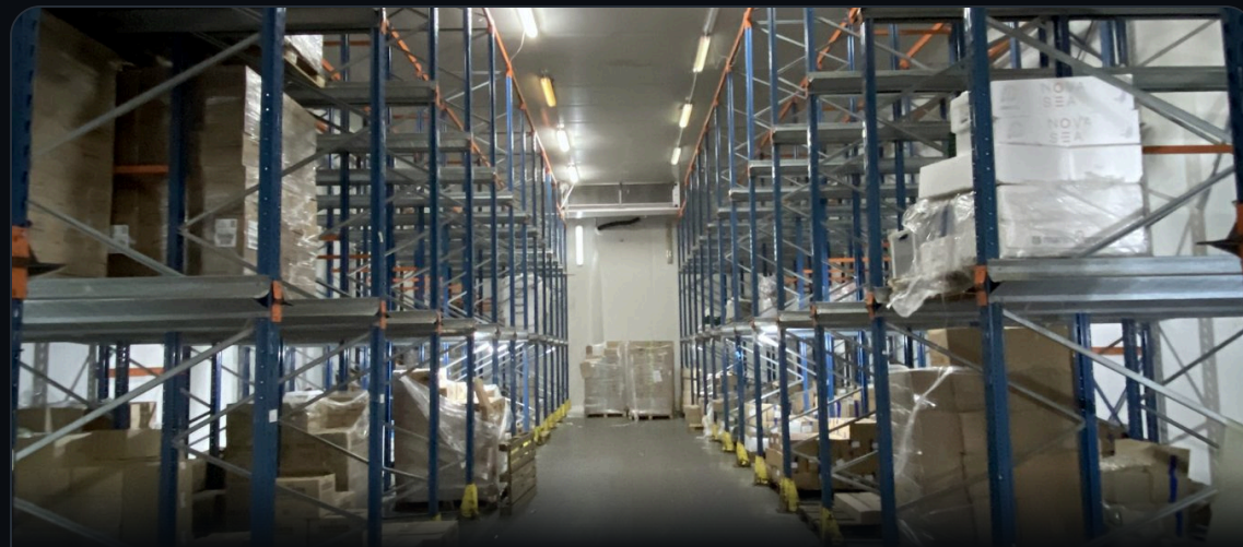
Морозильна камера -18 °С: стелажна система
