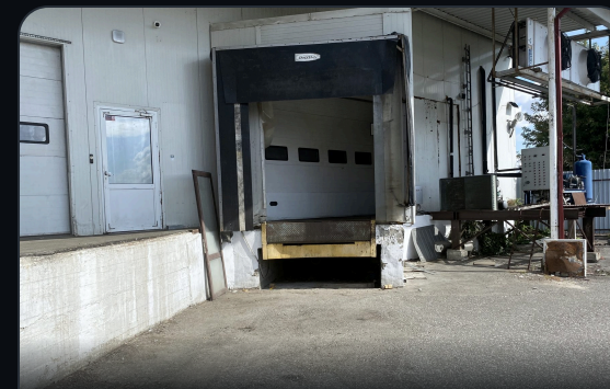
Доковий вузол: вирівнювач і докшелтер
